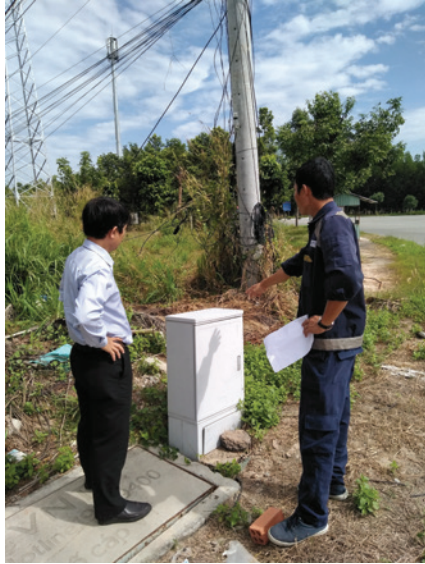
P.KTVT kiểm tra hạ tầng cáp quang viễn thông để tiến hành cải tạo
