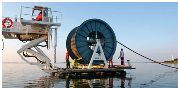
Từ cuối tháng 4/2020 đến đầu tháng 6/2020, đã có tới 3 tuyến cáp quang biển quốc tế gồm AAG, APG và AAE-1 gặp sự cố, phải sửa chữa. (Ảnh: The Verge)
