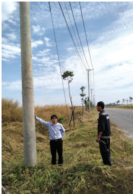
P.KTVT kiểm tra hạ tầng cáp quang viễn thông để tiến hành cải tạo
