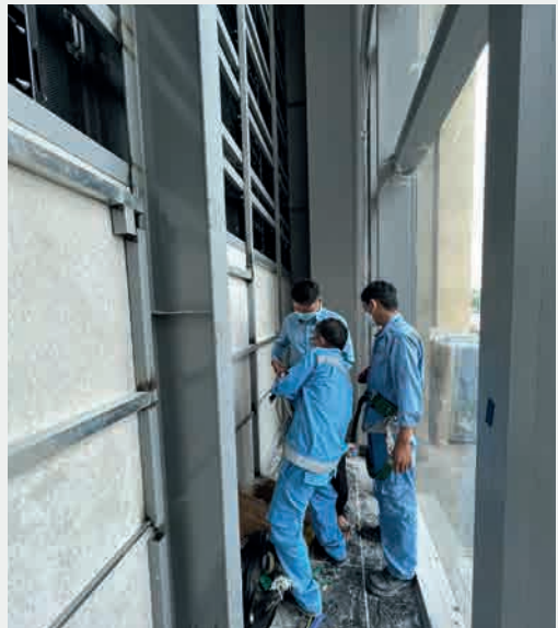
Phòng Dự Án thi công hệ thống màn hình tại trung tâm IOC
