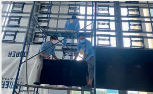
Phòng Dự Án thi công hệ thống màn hình tại trung tâm IOC
