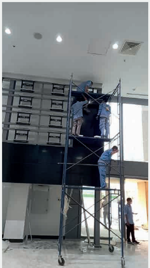
Phòng Dự Án thi công hệ thống màn hình tại trung tâm IOC
